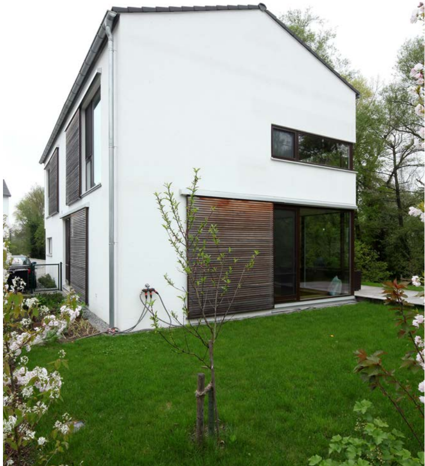
Trotz dicker Dämmung auf dem Dach sind Traufe und Ortgang knapp und feingliedrig ausgebildet.
