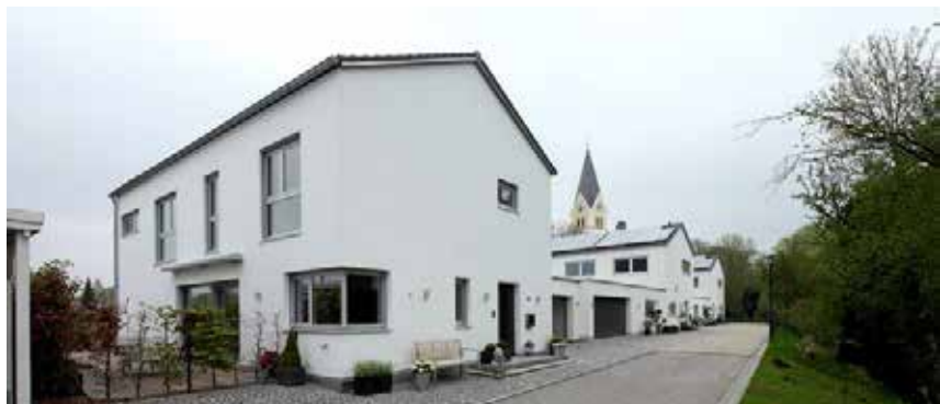
Unweit des alten Dorfkerns sind neue Wohnhäuser entstanden, die über ein Wärmenetz versorgt werden.
