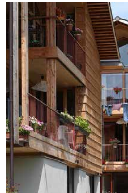
Der Wechsel von horizontal verlegter Holzschalung und vertikalen Holzstämmern, von geschlossenen Flächen und offenen Zwischenräumen erzeugt eine ausgewogene Dynamik.
