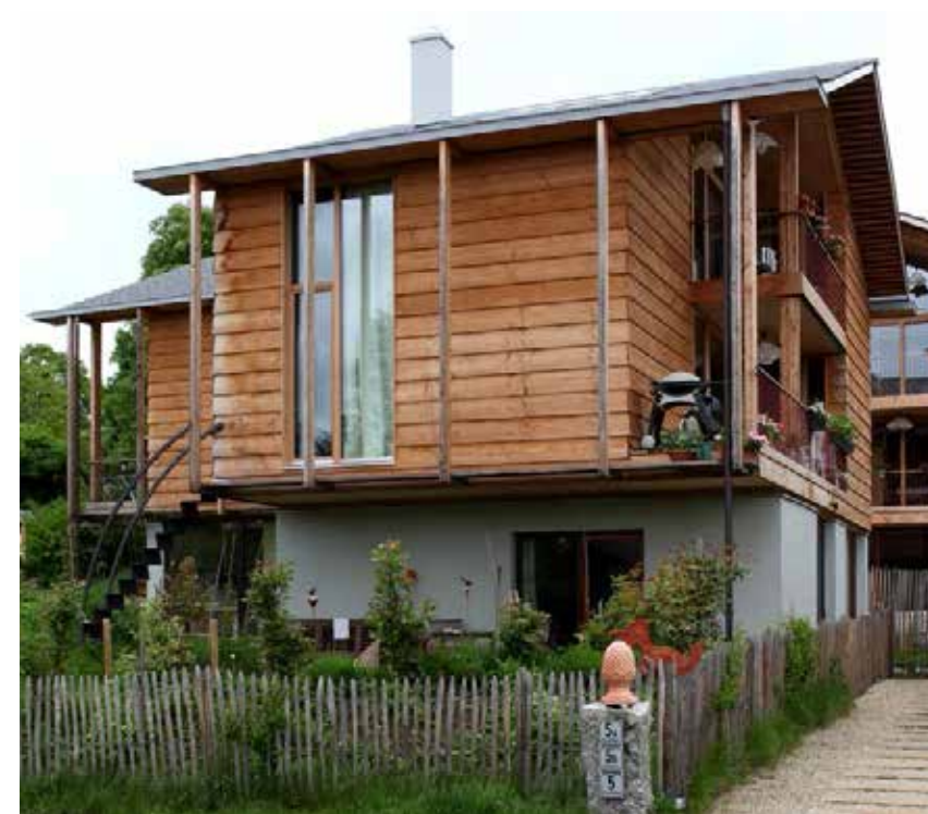
Zu den Sonnenseiten hin öffnen große Fensterflächen die Gebäude. Sie lassen Ausblicke in die Landschaft zu und bringen Licht und Sonne ins Innere. Problemlos lassen sich Geländer und Treppe an das Holz anbinden.
