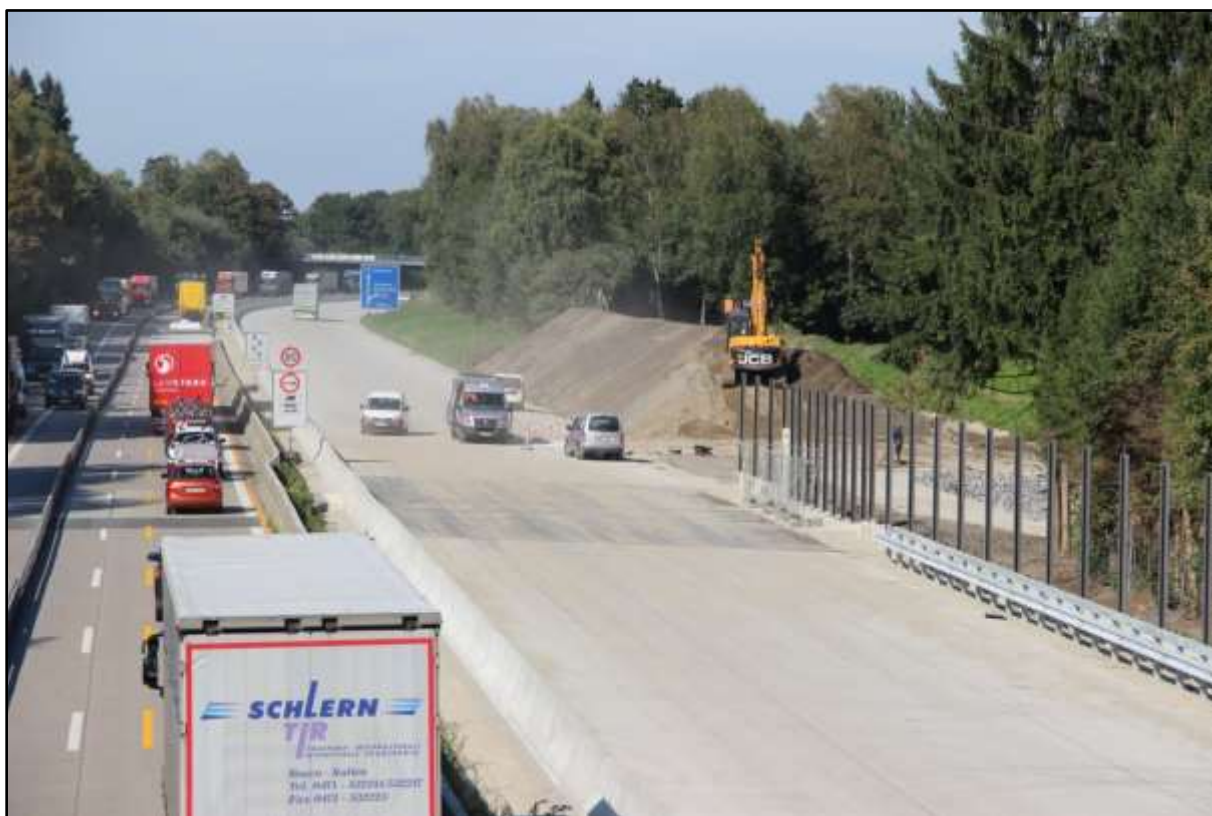
Abbildung 1: Laufende Baumaßnahmen an der Bundesautobahn A 93 [1]
