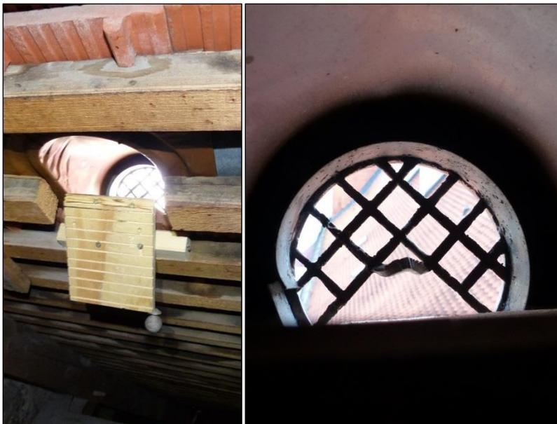
Abb. 9,10: Vermutlich für Fledermäuse als Ausflug eingebauter Lüfterziegel mit Detail der Aussparung in der Vergitterung
