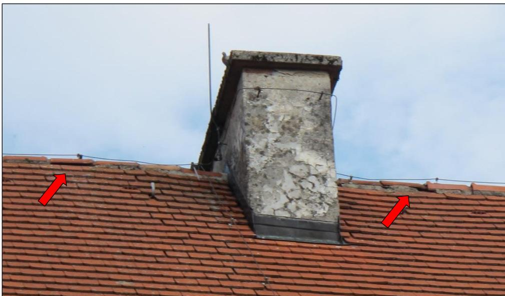
Abb. 14: Detail des Daches mit Lage der aktuell genutzten Ausflugsöffnungen bei defekten Firstziegeln (rote Pfeile)
