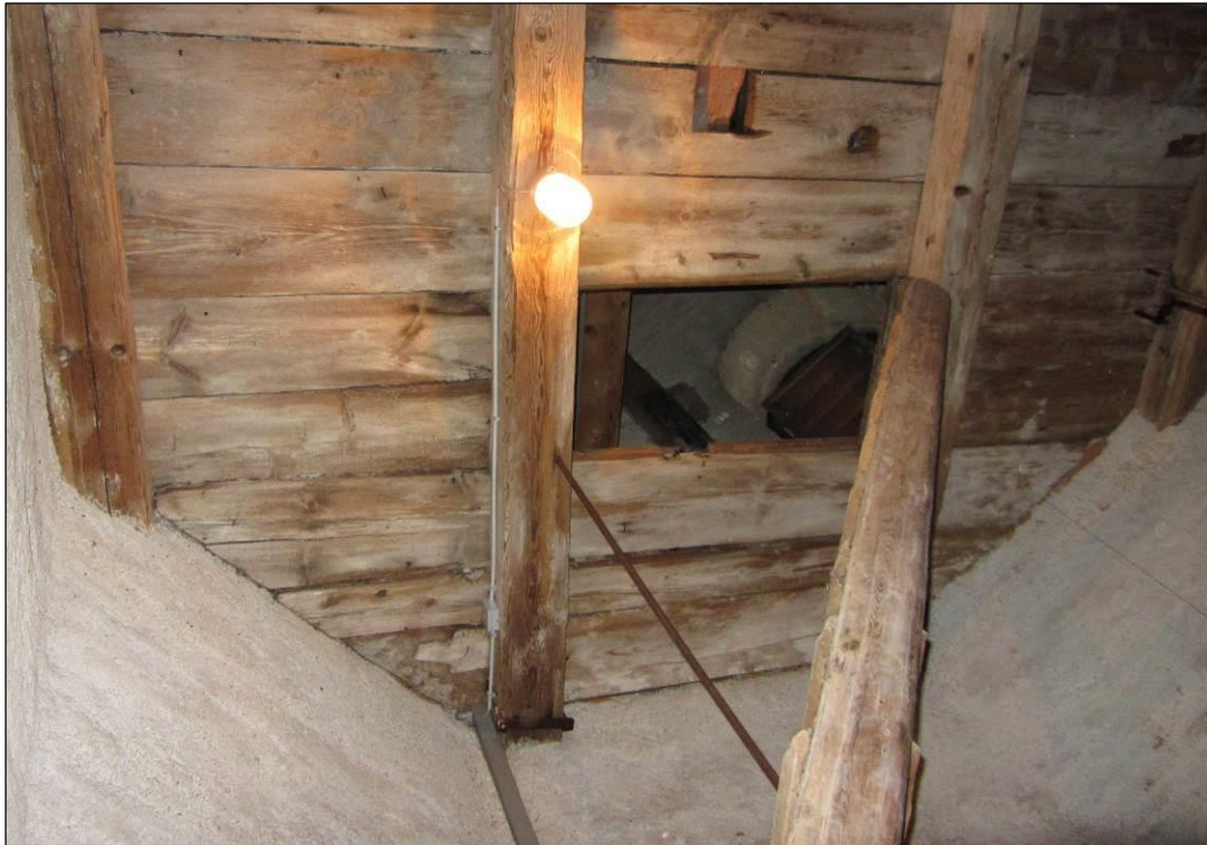
Abb. 16: Luke als Durchflug zwischen Turm und den Ausflugsöffnungen der unteren Ebene, Beleuchtung unterhalb der Luke.
