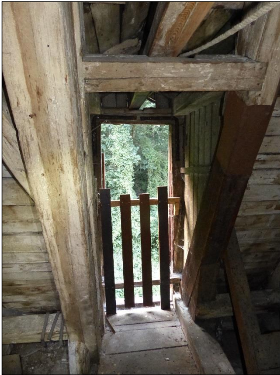
Abb. 14: Hauptausflug der Kolonie über eine Türöffnung auf der Nordseite.
