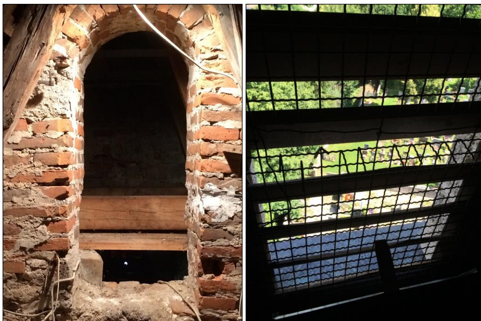
Abb. 18, 19: Durchflug zwischen Turm und Dachboden, vergitterte Schallluken
