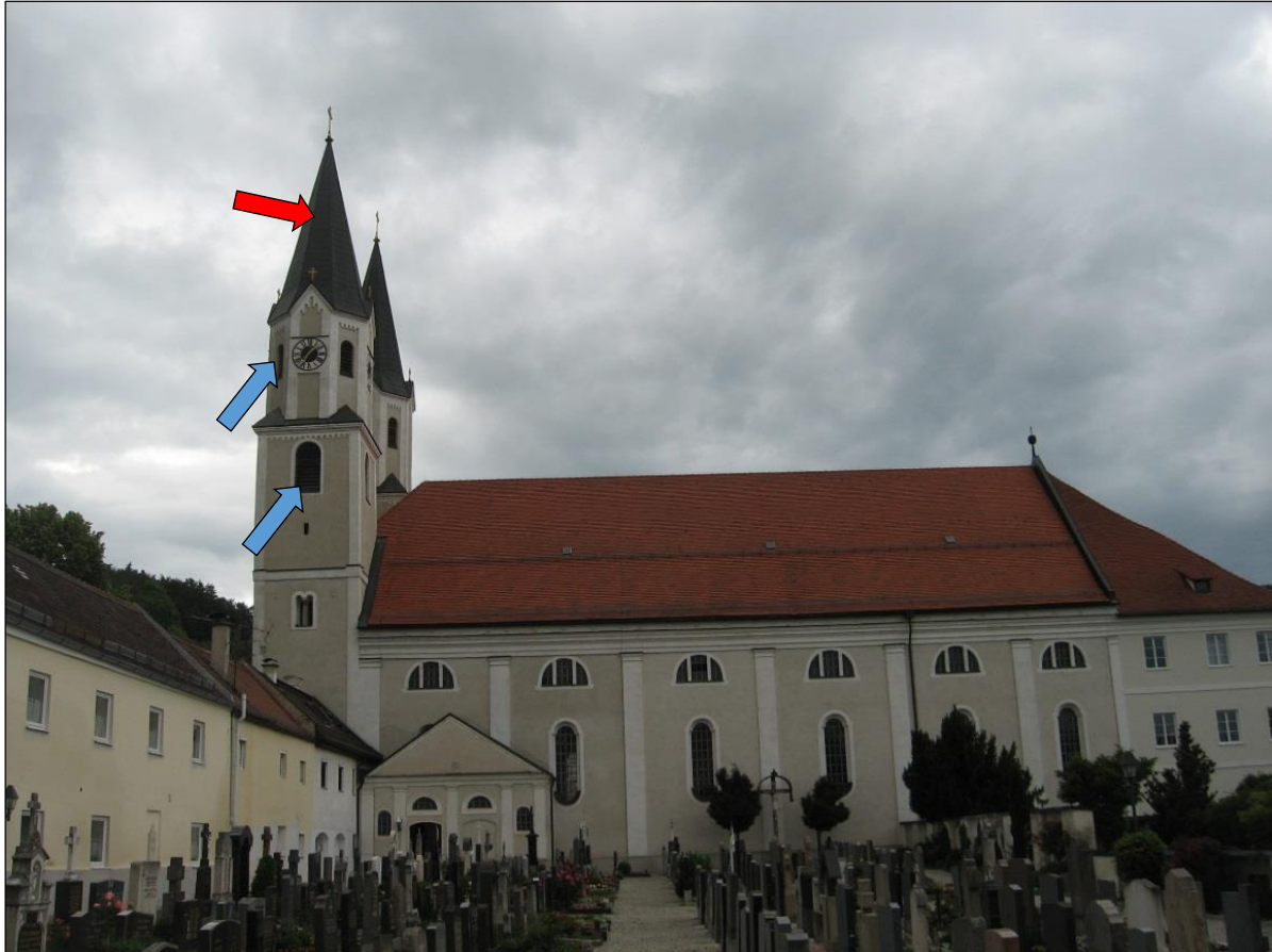
Abb. 15: Ansicht der Kirche in Gars von Süden, Kolonie bewohnt den südlichen Turm (roter Pfeil), Ausflug über alle unteren und oberen Schallluken (blaue Pfeile).
