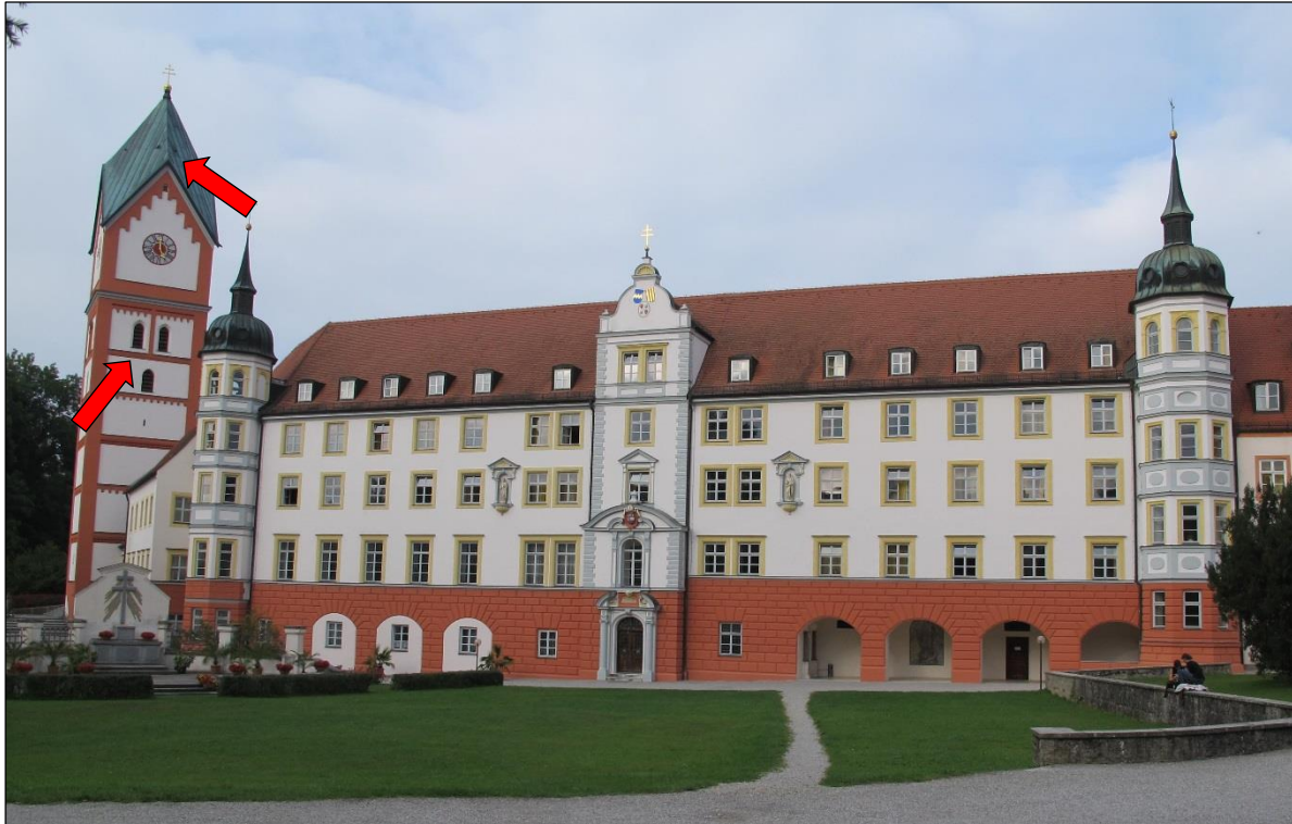
Abb. 17: Teilansicht des Klosters, Hangplätze (roter Pfeil) und Schallluken (blauer Pfeil) sind hervorgehoben.
