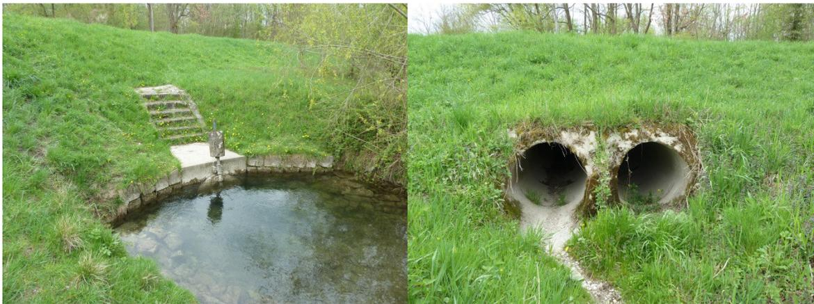
**Abbildung 11: Einleitung R. Binnenentwässerungsgraben (paarseitig) und zwei benachbarte, nicht regulierbare Rohrdurchlässe**
