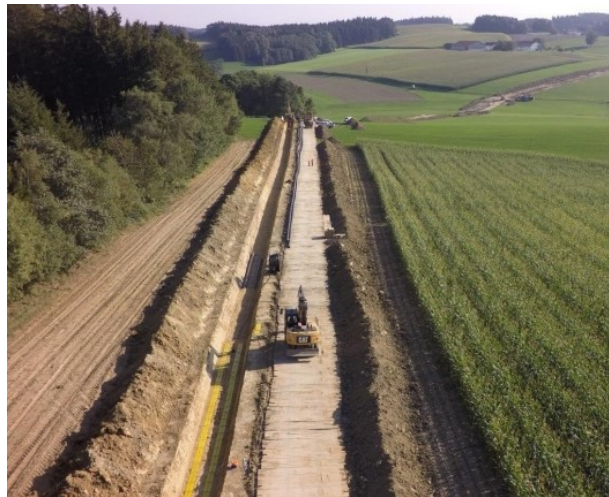
Abbildung 1: Verlegung einer Erdkabelleitung in offener Bauweise
