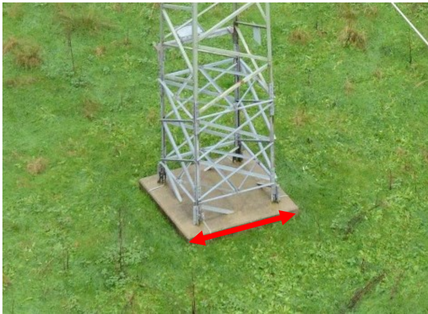
Abbildung 2: Sichtbarer Fundamentblock und Bodenaustrittsmaß
