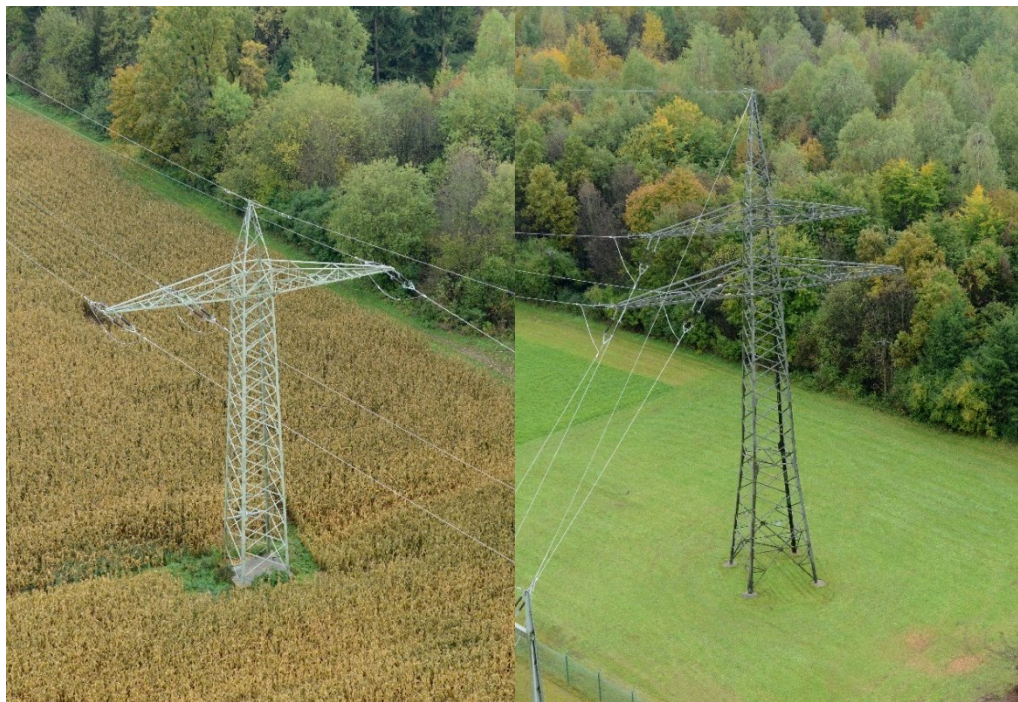
Abbildung 6: Einebenenmast und Donaumast
