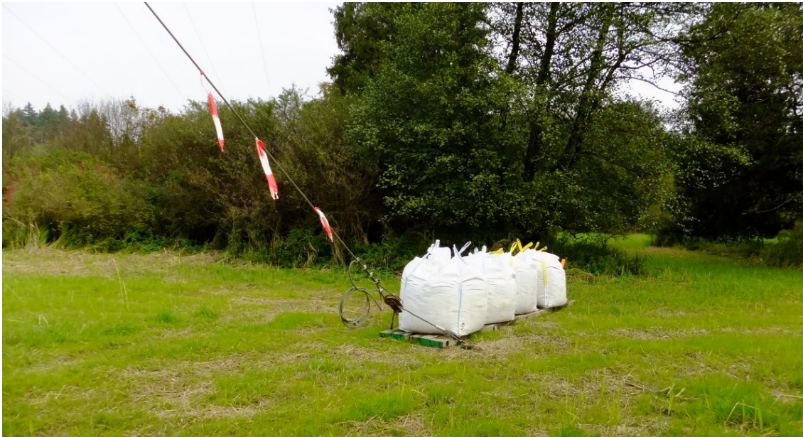
Abbildung 16: Abankerung mittels Ballastschlitten
