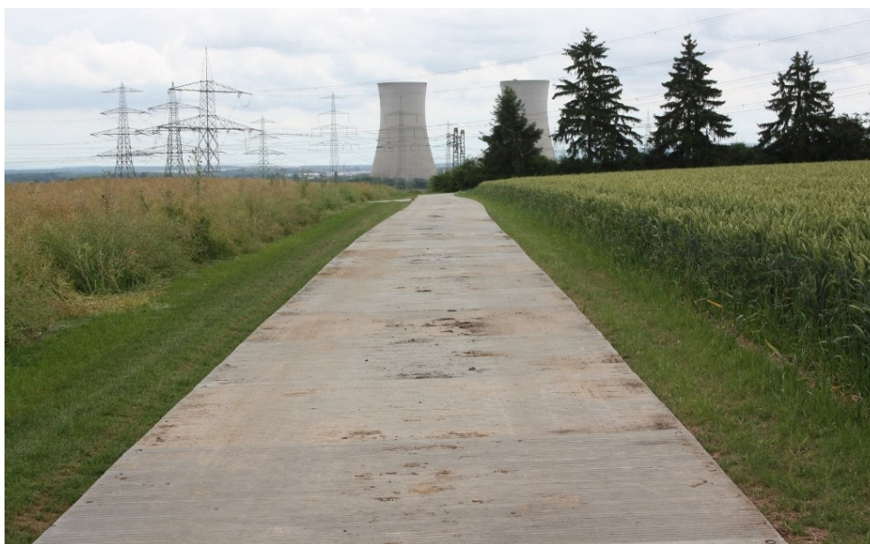
Abbildung 10: Zuwegung über Aluplatten (schwerer Wegebau)
