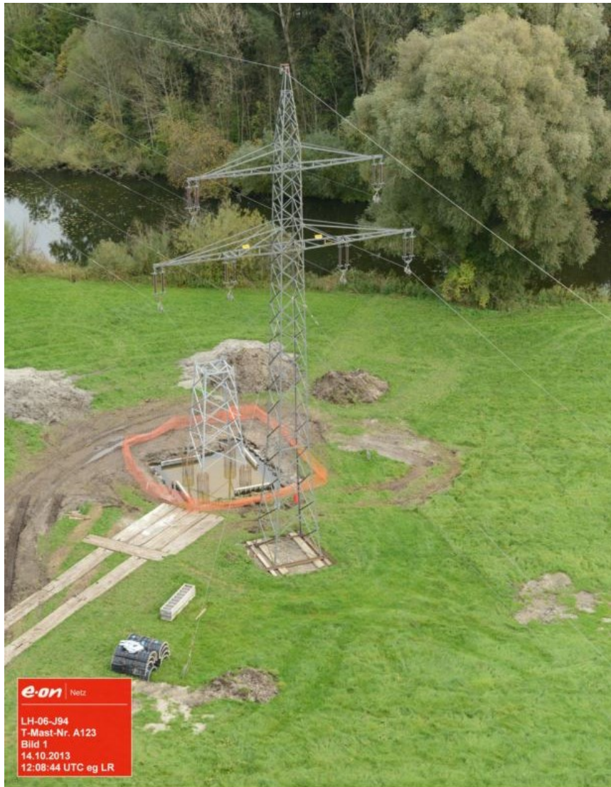
Abbildung 13: Arbeitsfläche 2013 für den Einbau eines neuen Unterteils des Masts A123 Ltg Nr. J94
