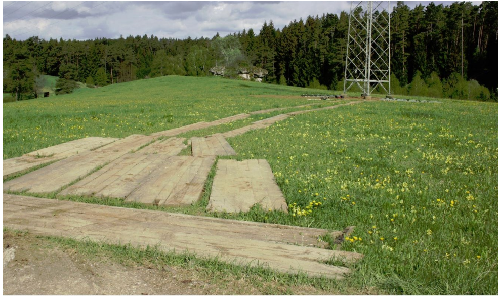
Abbildung 11: Zuwegung über Holzplatten (leichter Wegebau)
