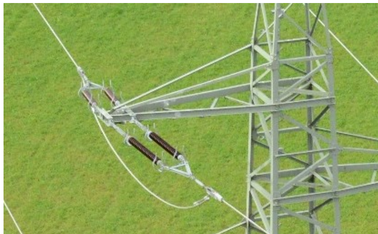
Abbildung 9: Abspannketten
