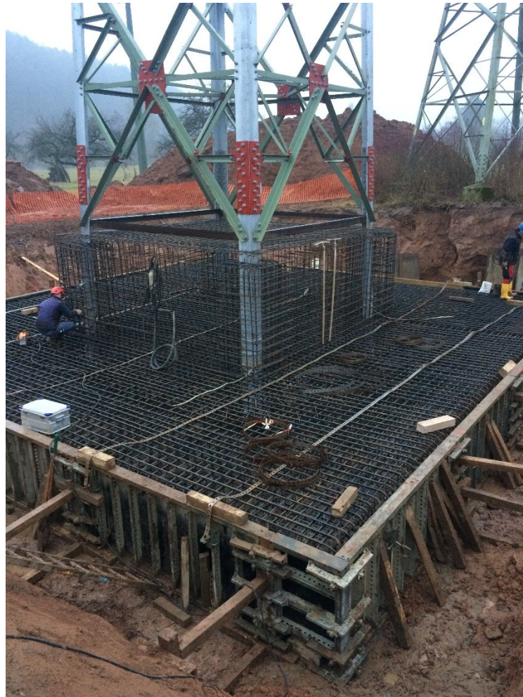
Abbildung 17: Beispiel für Fundamentarbeiten (Plattenfundament) , Schalung und Bewehrungsstahl
