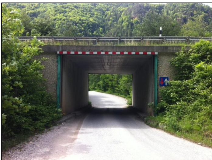
Abbildung 2: Überführung der Bundesstraße B21 im Bereich des bestehenden Abbaureals
