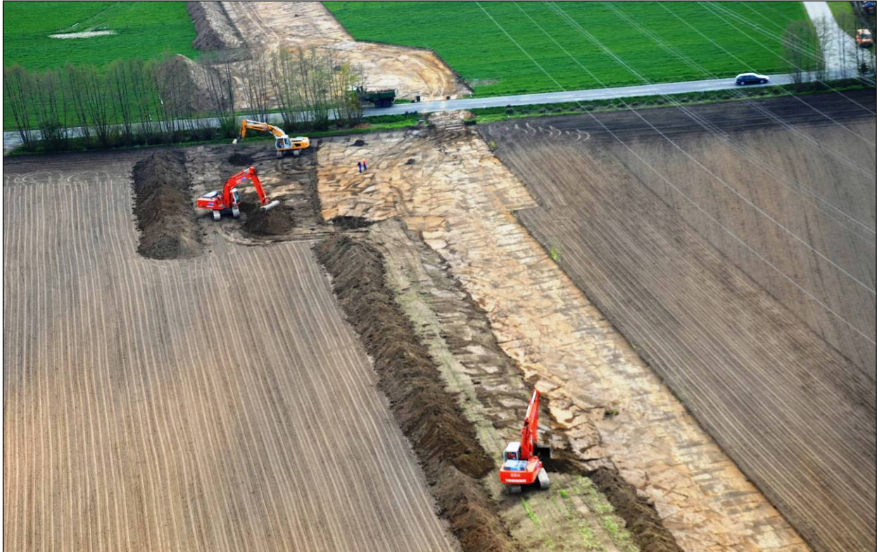
Abbildung 6: Abschieben und Lagern des Oberbodens
