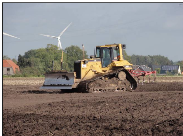
Abbildung 10: Rekultivierung des Arbeitsstreifens
