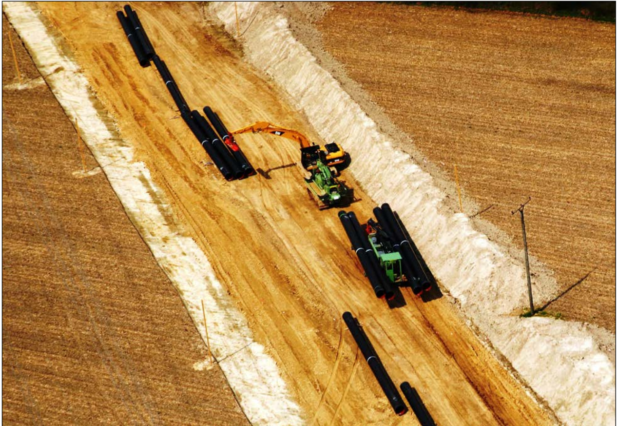
Abbildung 7: Rohrausfuhr im Arbeitsstreifen
