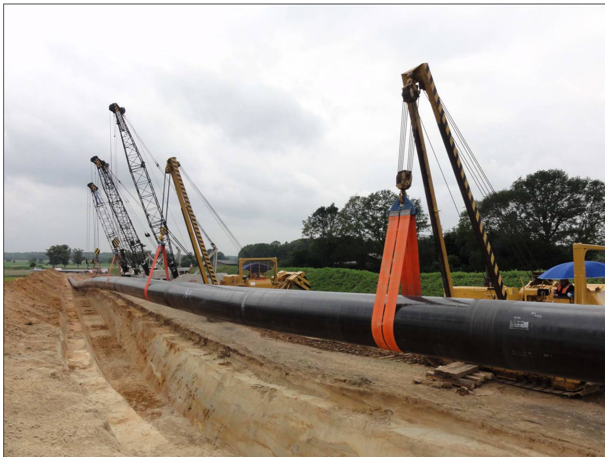
Abbildung 8: Absenken des Rohrstranges
